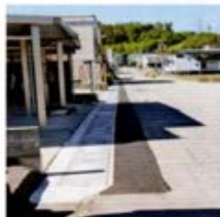
枠外での側溝工事
